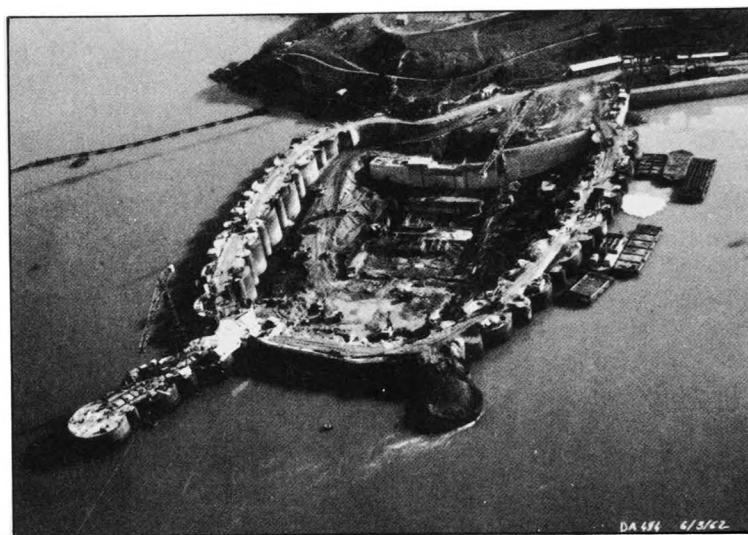
FIG. 7. — Rive droite. Construction des pertuis et du batardeau de la digue-usine (6 mars 1962).
