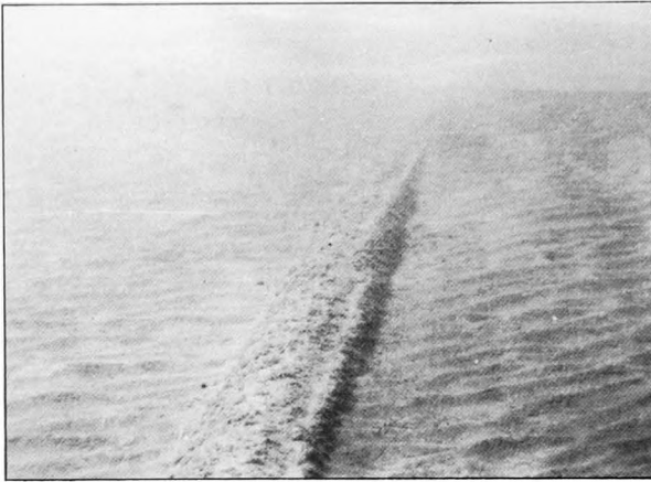
FIG. 3. — Pipe-line à moitié enterré dans le sable sous 40 feet d'eau.
