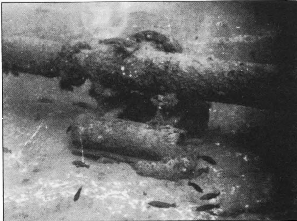
FIG. 4. — Pipe-line sous 55 feet d'eau.
