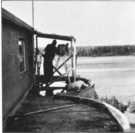
FIG. 2. — Station éloignée Hydrodist sur un silo à blé. Une autre station VHF derrière l'opérateur.
