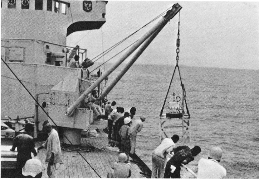
FIG. 4. — Handling the tide gauge aboard R.I. Burudjulasad .
