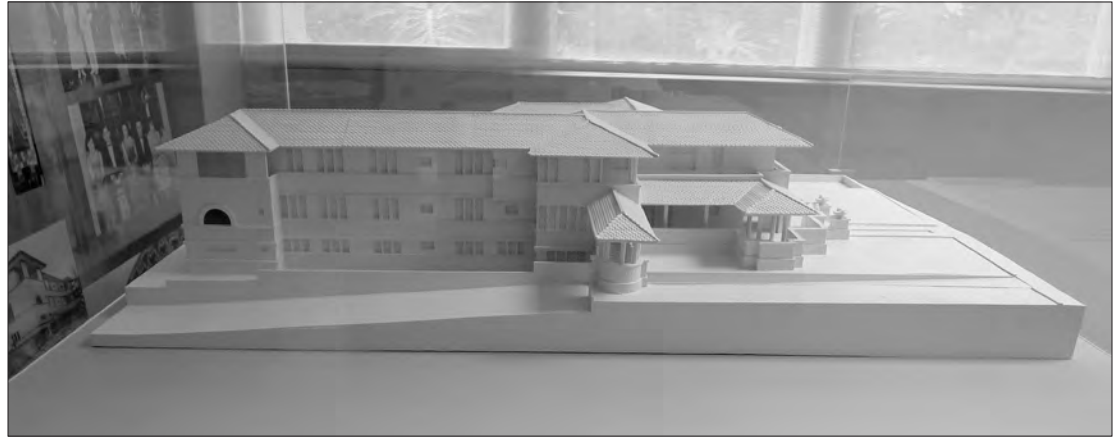
Fig. 5 Scale model of Georgetti House. The porte cochere consists of a long, roofed overhang on the side of the building. Archivo de Arquitectura y Construcción de la Universidad de Puerto Rico.
