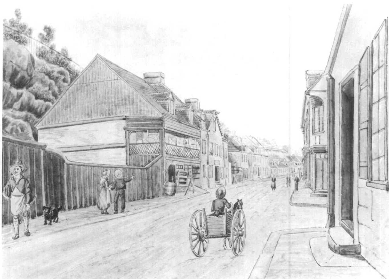
Fig. 3. «Une rue du faubourg Saint-Roch 1830». Artistes et voyageurs ont rarement pénétré dans Saint-Roch, sans doute à cause du peu d'inspiration que leur offrait ce quartier populaire aux rues mal entretenues et aux maisons souvent délabrées. James Patterson Cockburn fait une exception avec cette aquarelle représentant la rue Saint-Vallier en direction de l'ouest. Notons toutefois que cette rue n'est pas la plus représentative du faubourg car elle attire très tôt commerçants et gens aisés. Par exemple, en 1817 et 1818, le marchand Charles Rochette et l'entrepreneur en bâtiments Jean Guillet dit Tourangeau se font construire des maisons en pierre de deux et trois étages et le meublier Thomas Hobbs qui a déjà pignon sur rue à la Haute-Ville fait de même en 1819. (Photo: Royal Ontario Museum, 951 X 205.9.)
