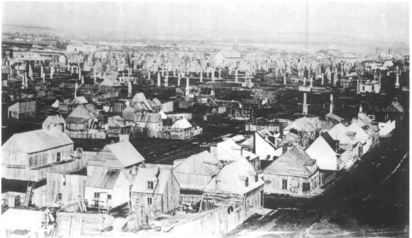
Fig. 12. Cette photo prise après le feu de 1866 qui ravage une partie de Saint-Roch et de Saint-Sauveur nous donne une excellente idée de la qualité de l'environnement et des différents types de maison ouvrière qu'on trouve à Saint-Roch dans la première moitié du XIXe siècle. La plupart sont à pignon et n'ont qu'un étage avec grenier mais plusieurs ne sont que de simples appentis dont on perce le toit pour faire une lucarne. (Photo: Archives publiques du Canada, 944372)
