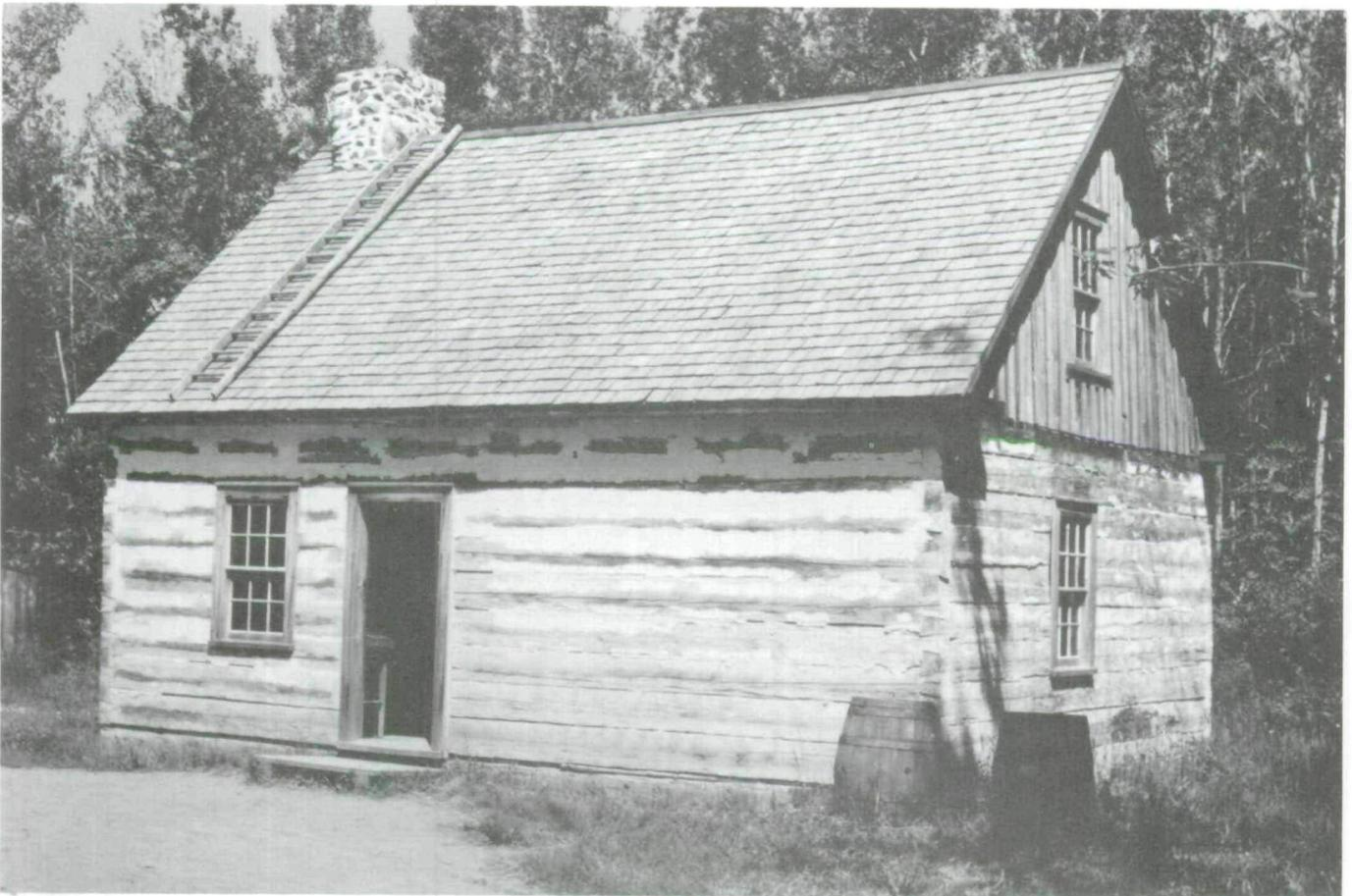
Fig. 6. Structure massive. Pièce sur pièce à assemblage d'angle en queue d'aronde dans une maison du village acadien de Caraquet. (Photo: Georges-P. Léonidoff.)
