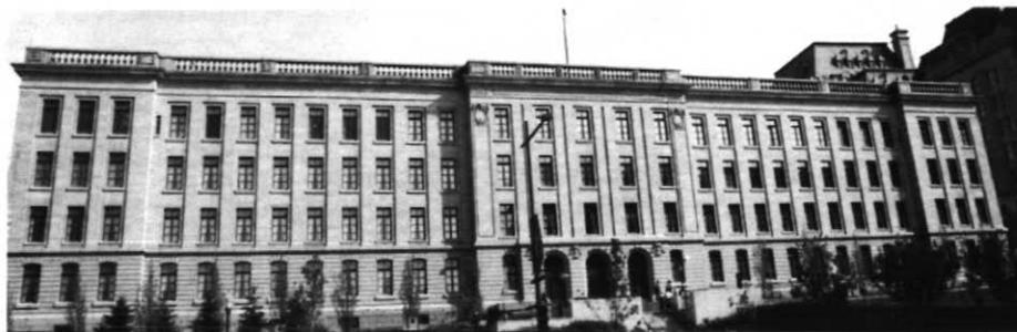
Figure 8 Édifice Honoré-Mercier, érigé en 1922, embasement en granite rouge de Charlesbourg, rez-de-chaussée en granit Gris-Bleu de Rivière-à-Pierre, et les étages en calcaire de la Formation de Deschambault de Saint-Marc-des-Carières.
