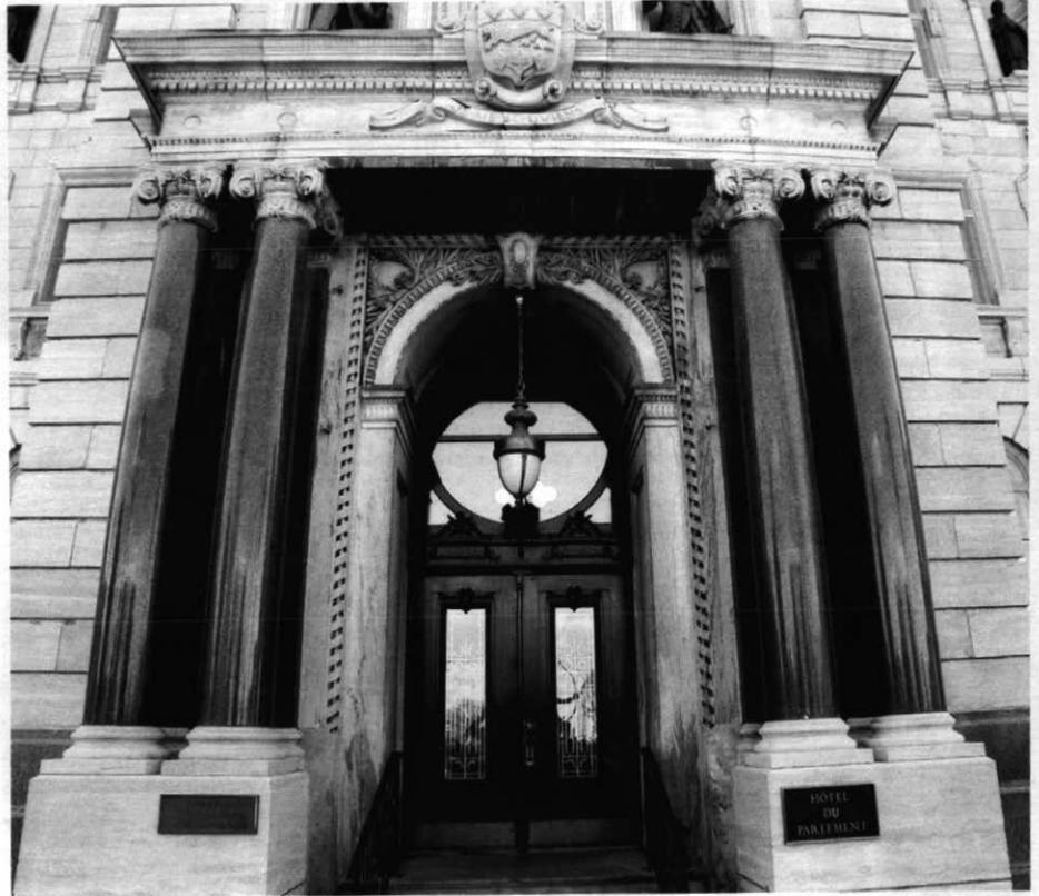
**Figure 6** Portail de l'entrée d'honneur de l'Hôtel du Parlement décoré de colonnes et pilastres en granite de Quincy du Massachusetts; chapiteaux ioniques, voute, tympan, ruban spiralé et lambris en calcaire de Terrebonne (Groupe de Chazy); socles des colonnes, entablement et cartouche des armoiries en calcaire de la Formation de Deschambault de Saint-Marc-des-Carières.
